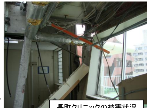
長町クリニックの被害状況
