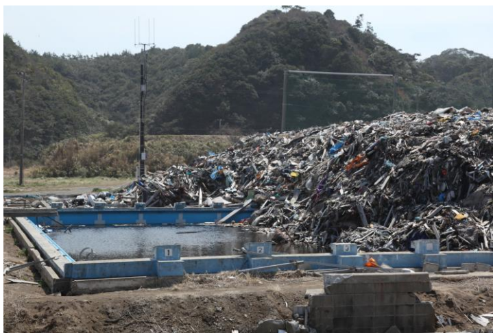
津波被害のあと瓦礫置き場となっている、いわき市立豊間中学校
