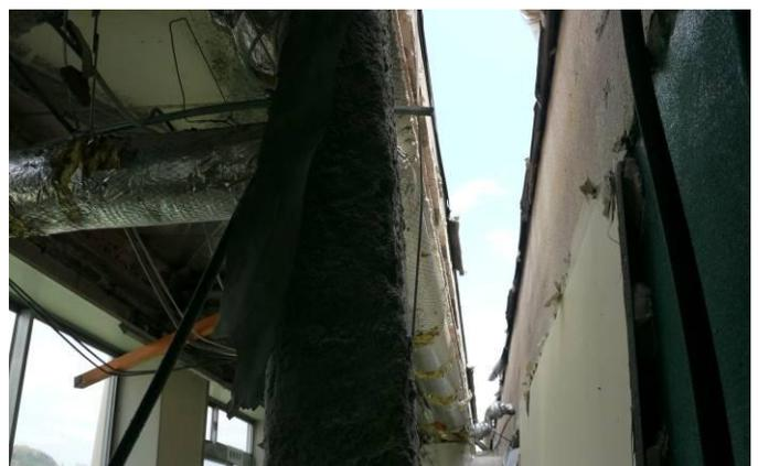
↑長町クリニックを視察。余震の度に建物の隙間が拡大、倒壊しないよう建物をワイヤーロープで引っ張っている。
